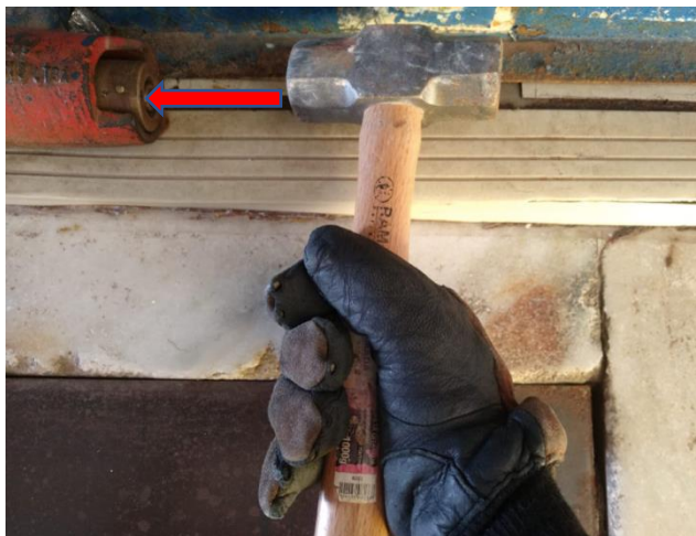
Figura 13: Utilização de golpes de marreta no lado oposto ao de encaixe da chave.
