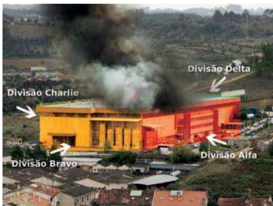
Figura 2 - Divisão em fachada num incêndio urbano
