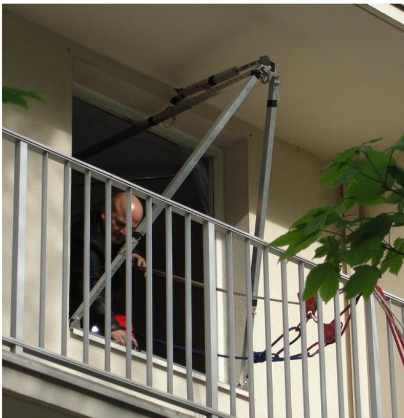
Figura 12 – Peça opcional do SIAM que projeta um ponto de desvio para fora da janela)
