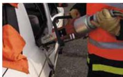
Figura 13 - Criação de ponto de apoio para o alargador
