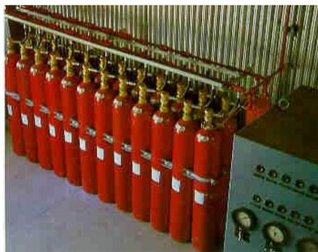
Figura 76 - Cilindros de HFC-227
