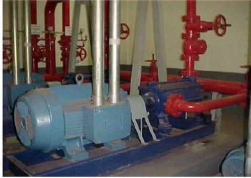
Figura 61 - Bomba de pressurização dos chuveiros automáticos
