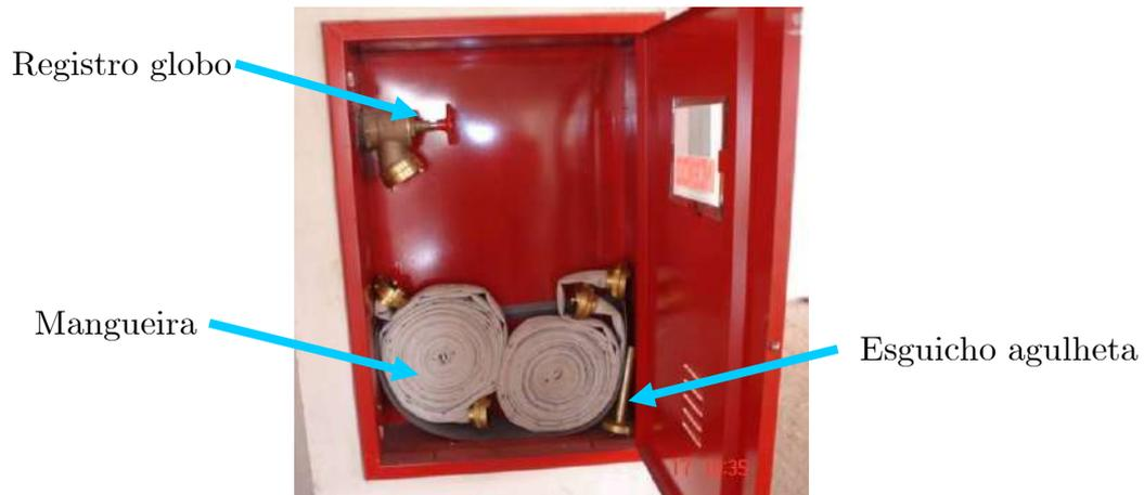
Figura 44 - Hidrante de parede
