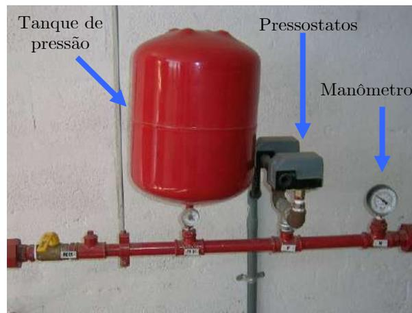
Figura 45 - Tanque de pressão, manômetro e pressostato
