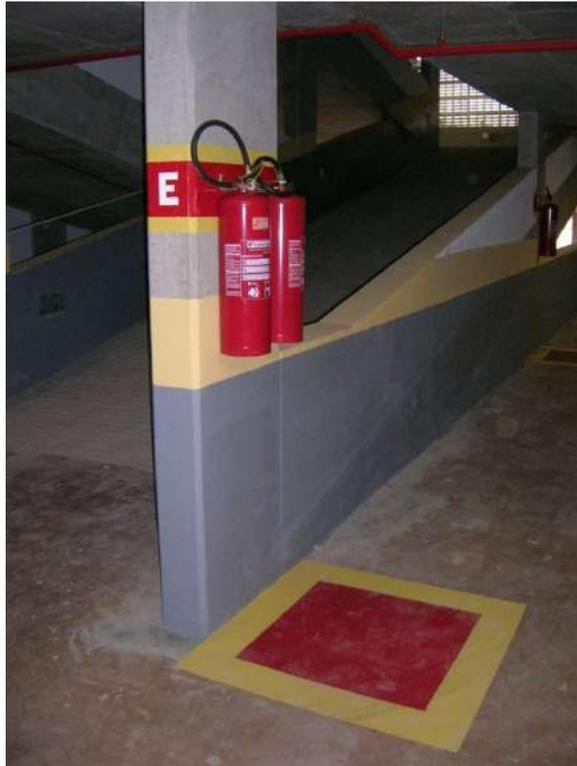
Figura 42 – Sinalização de piso e de coluna para extintores
