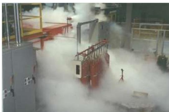
Figura 72 - Sistema de CO<sub>2</sub> em funcionamento
