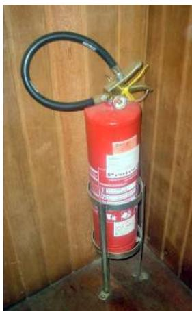
**Figura 41 - Extintor sobre suporte a 0,20m do piso**
