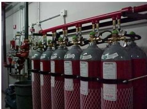
Figura 78 - Cilindros de gás argonite
