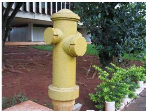
**Figura 52 - Hidrante de coluna (ou hidrante urbano)**
