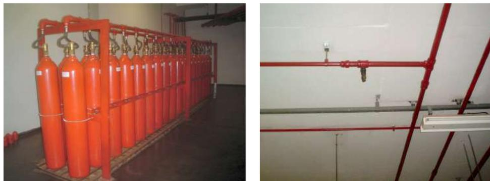
Figura 71 - Bateria de CO<sub>2</sub> e bico aspersor
