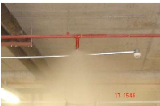
Figura 54 - Chuveiro automático - *sprinkler*
