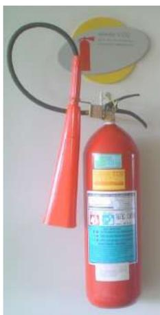
**Figura 40 - Extintor sobre suporte na parede**
