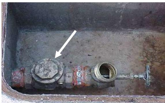
**Figura 50 - Hidrante de recalque com válvula de retenção**
