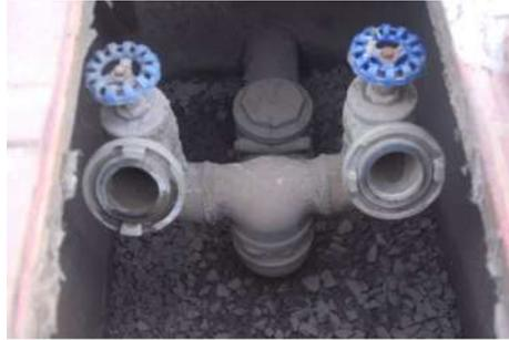
Figura 66 - Tomada de recalque da rede de *sprinklers*
