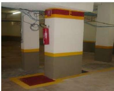
**Figura 37 – Sinalização de coluna e demarcação de piso**
