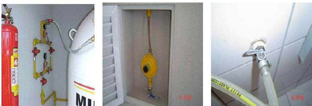
Figura 33 - Registros de corte na central, na prumada e no ponto de consumo, respectivamente
