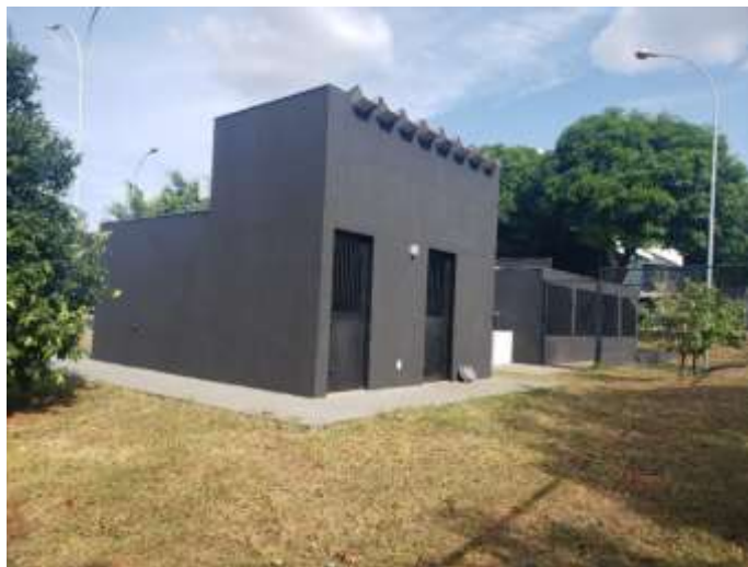
Figura 7 – Vista geral do canil da Polícia Civil do Distrito Federal.
