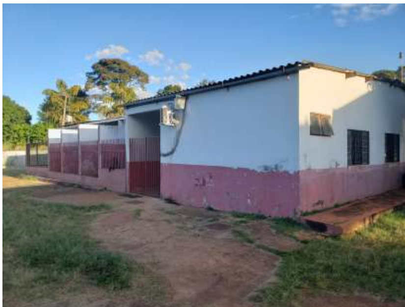
Figura 3 – Vista geral das instalações do canil do CBMDF.
