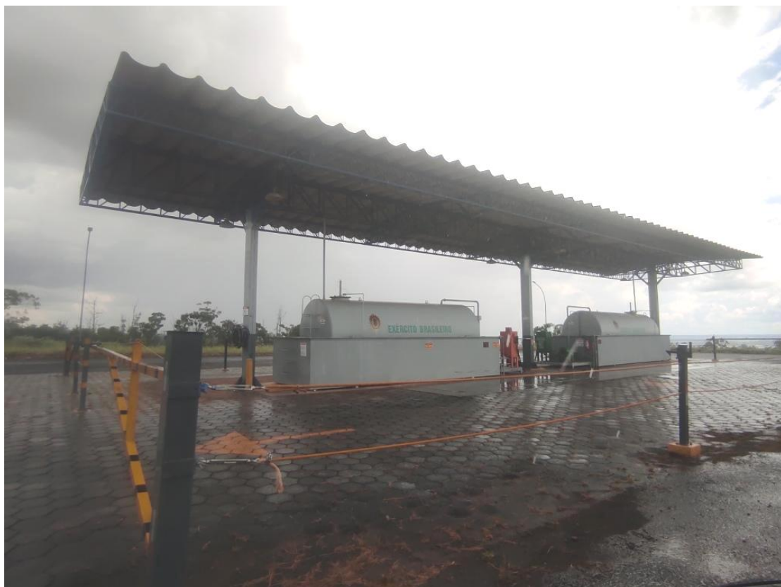
Figura 32 - CCOMGEX: Posto de combustível do Complexo
