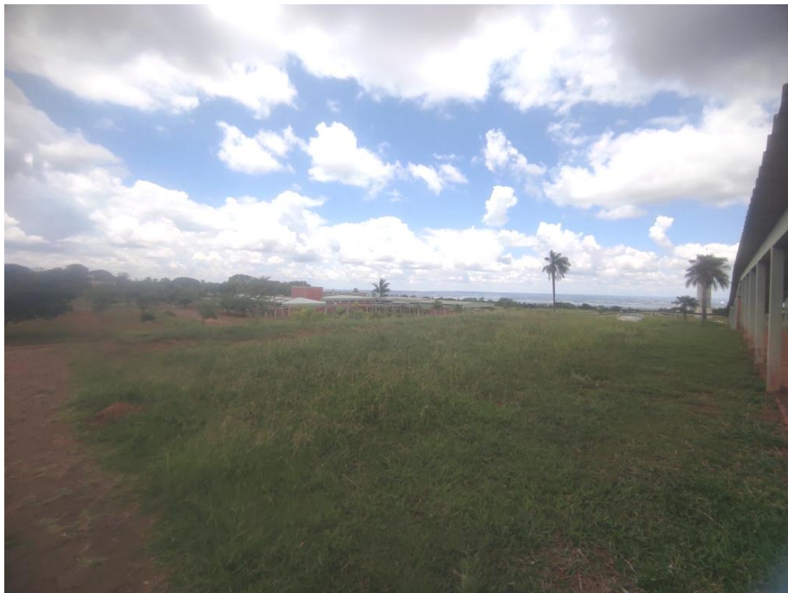
Figura 35 - CCOMGEX: Vista geral de parte das instalações
