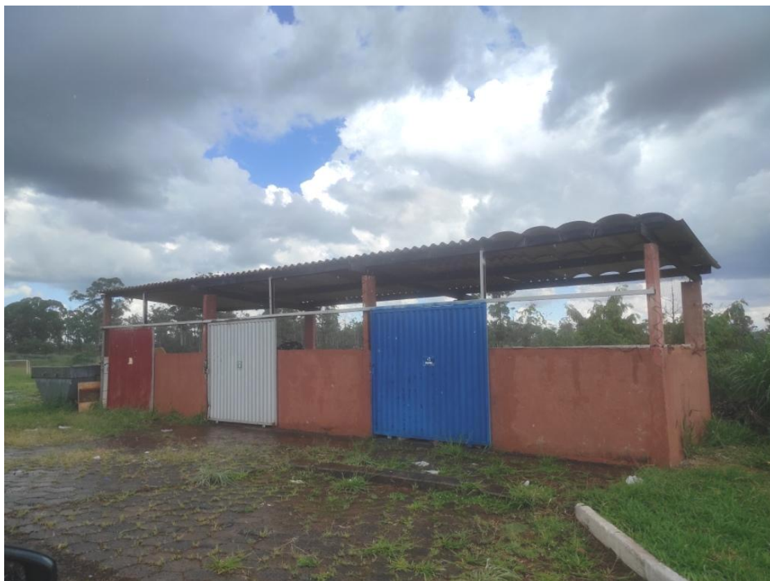
Figura 31 - CCOMGEX: Local para separação e armazenamento do lixo
