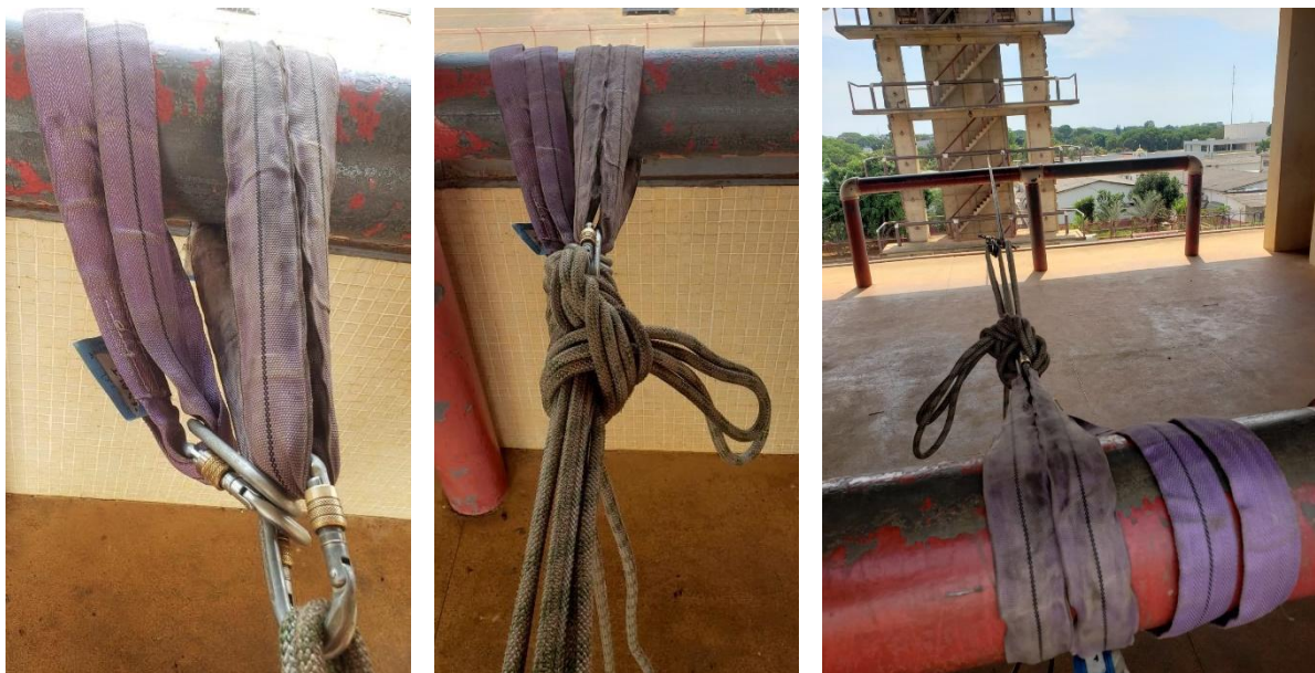
Figura 6 – Ancoragem primária na Torre Principal
