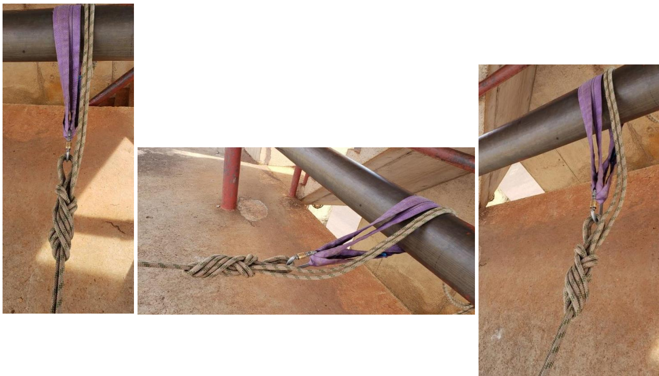
Figura 4 – Ancoragem primária indireta na Torre Auxiliar
