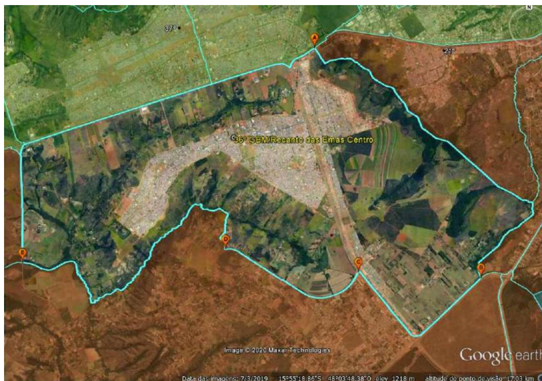
Figura 4 - Área operacional do 36º GBM
