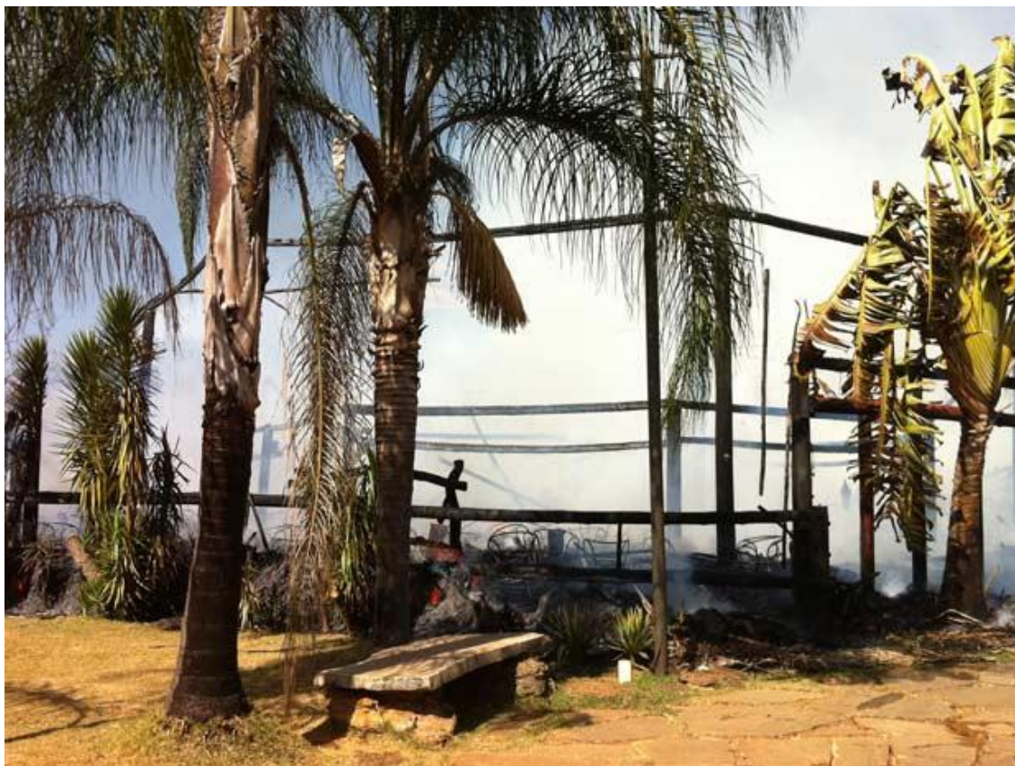
Figura 3: Estrutura do restaurante Oca da Tribo após o incêndio
