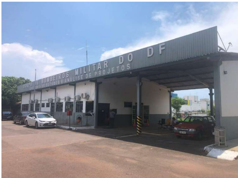
Figura 17 – Fachada da DIEAP
