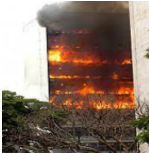
Figura 4 - Incêndio no prédio do INSS-DF
