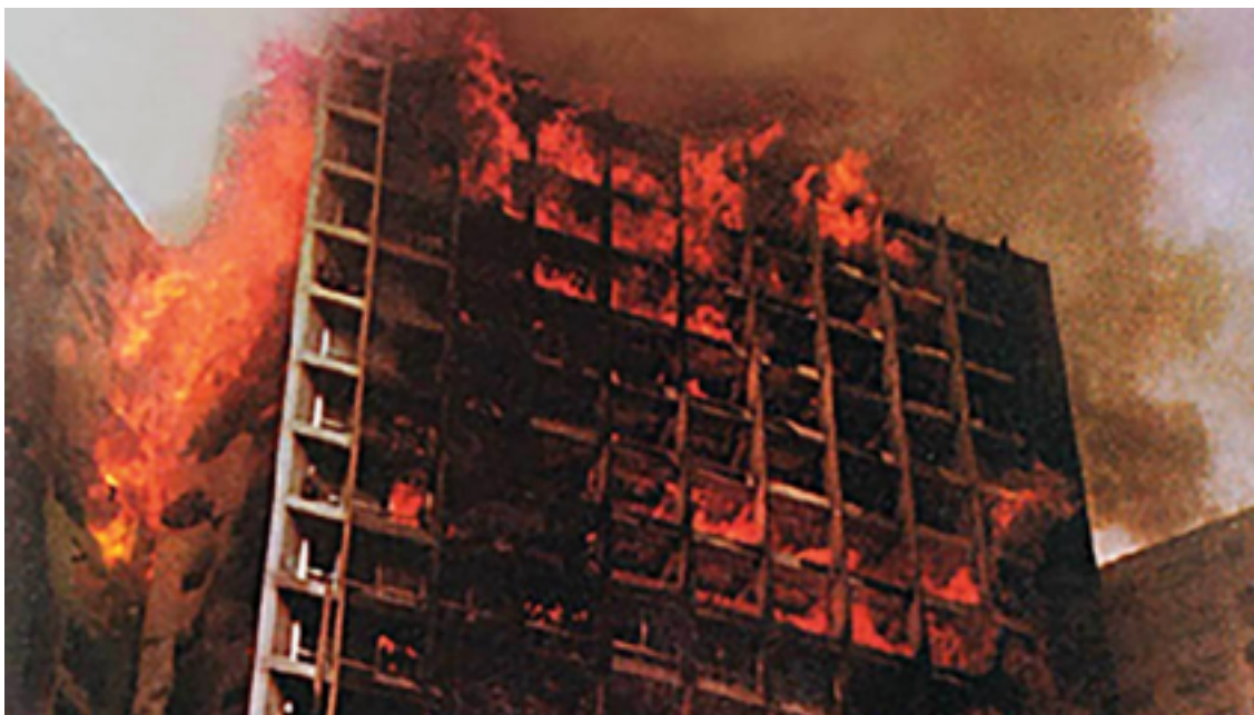
Figura 3 - Edifício Joelma em chamas
