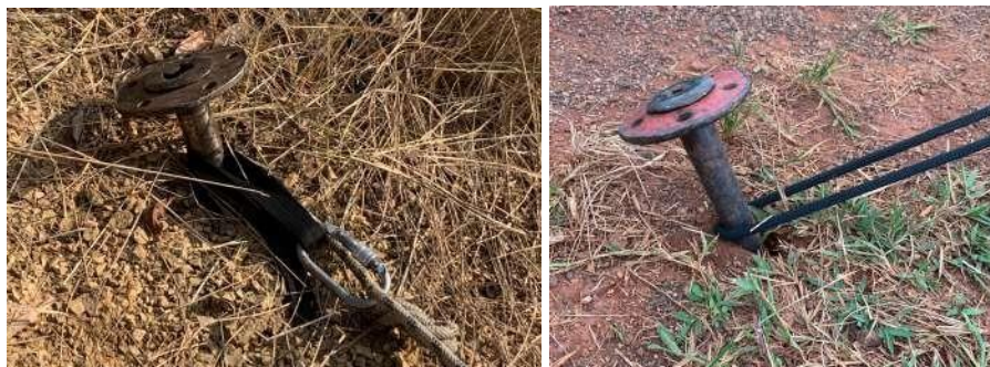
Figura 9 - Estaca vertical com 1 (uma) Ponta de Eixo
