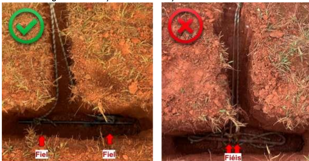
Figura 5 - Amarração no início do terço distal e centralizada na alavanca
