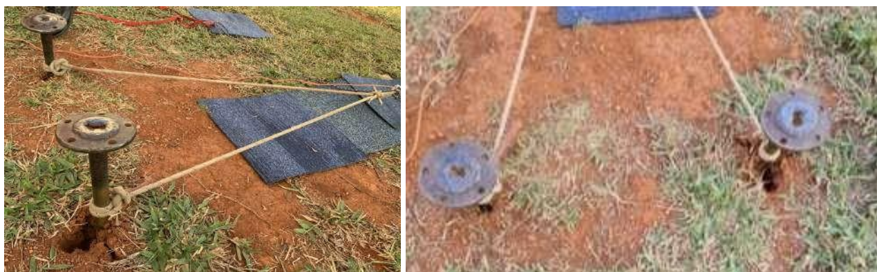
Figura 23 - Estaca dupla em paralelo com ancoragem equalizada após a tração destacando o avanço desigual
