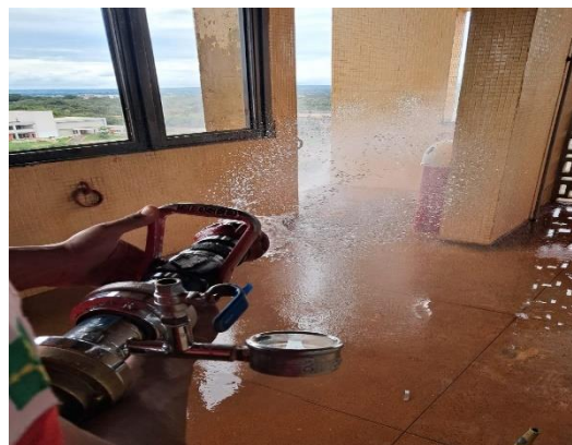
Figura 21 – Retirando ar do sistema
