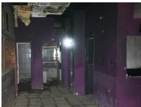
Figura 4-115 – Corredor de acesso aos banheiros.
