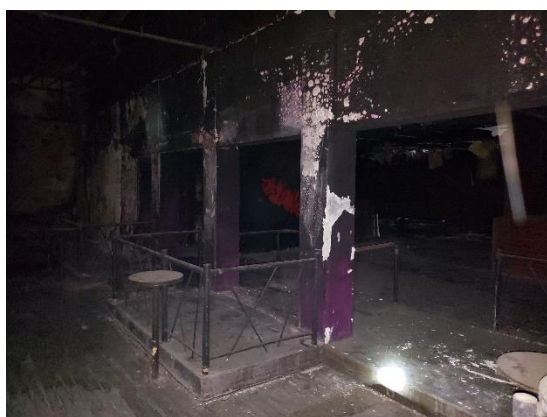
Figura 4-11 – Parede do palco principal.
