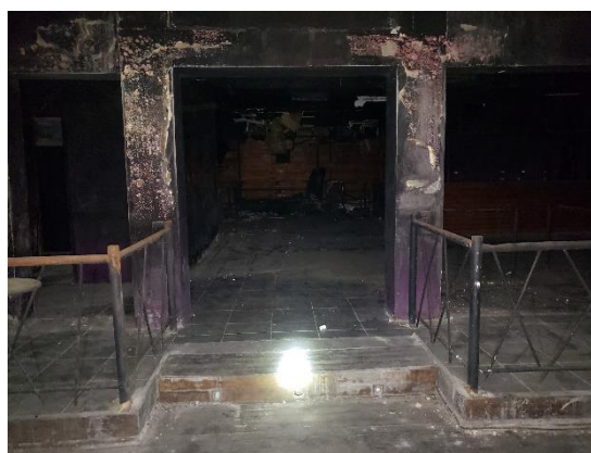
Figura 4-12 – Rota de fuga do palco principal.
