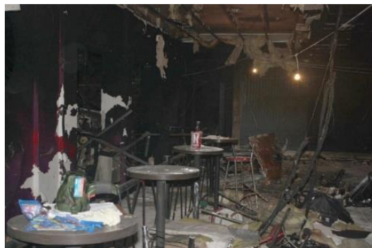
Figura 4-21 – Corredor principal da Kiss após o incêndio. Fonte: UFSM (2021).
