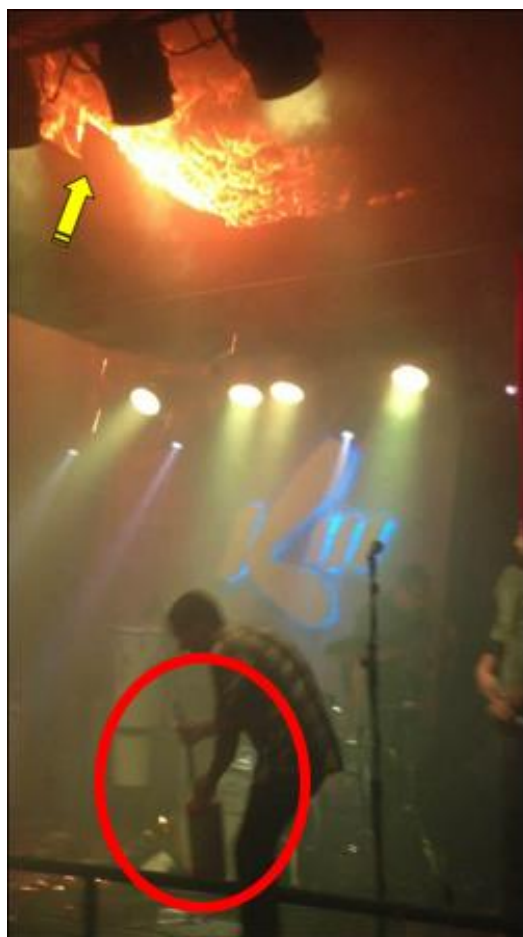
Figura 4-4 – Extintor existente próximo ao palco principal da Kiss. Fonte: Adaptado de Estado do Rio Grande do Sul (2013b).
