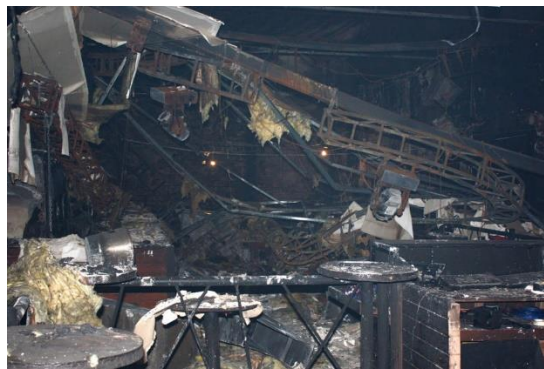
Figura 4-25 – Pista de dança principal após o incêndio.
