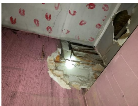
Figura 4-120 – Janela real do banheiro feminino.
