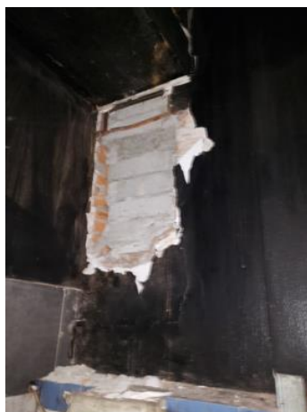
Figura 4-118 – Janela real do banheiro masculino.
