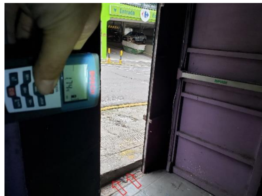
Figura 4-34 – Degrau singular existente na descarga.
