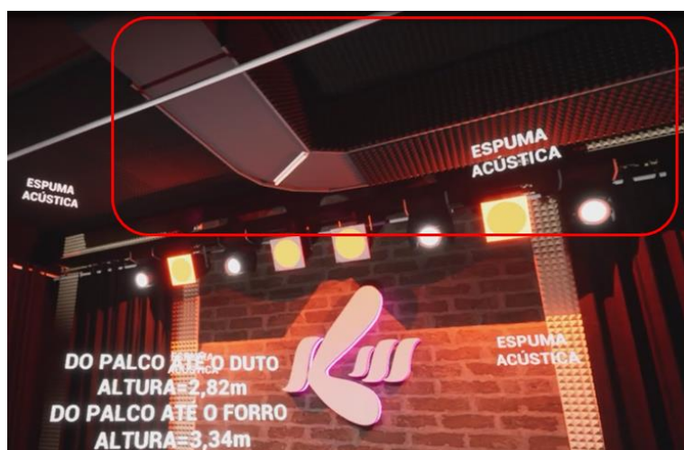
Figura 4-62 – Dutos do ar-condicionado e placas de espuma. Fonte: Adaptado de UFSM (2021).
